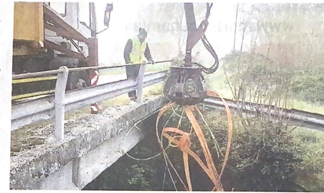
La rimozione dei rifiuti dal corso d'acqua
