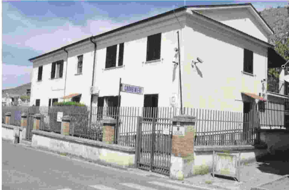
La caserma dei carabinieri di Roccasecca è nell'elenco di quelle per le quali l'Agenzia del demanio ha affidato il servizio di verifica della sicurezza strutturale
