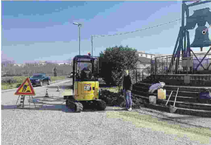
L'intervento della Provincia sul ponte del fiume Gari
