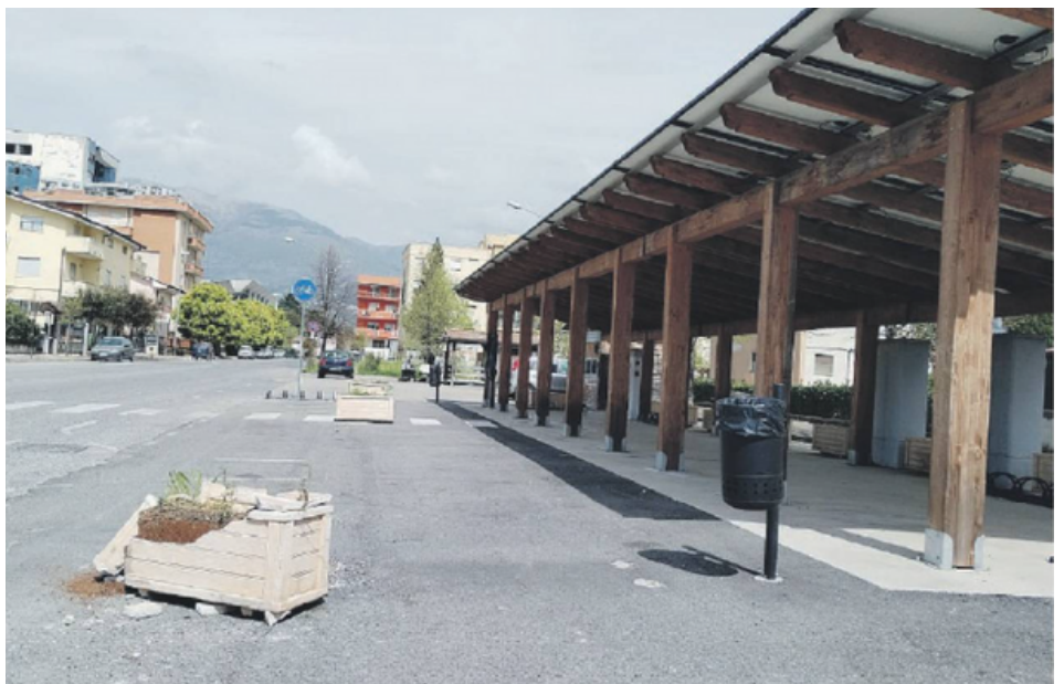
Il vaso travolto e distrutto davanti alla "ciclostazione" del quartiere San Giuliano
