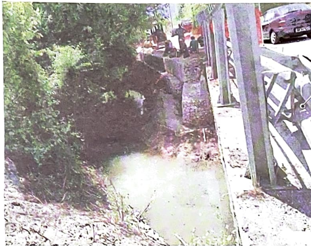
Alcune immagini del cantiere per i lavori di consolidamento del ponte sulla strada provinciale tra Ceprano e Castro dei Volsci
