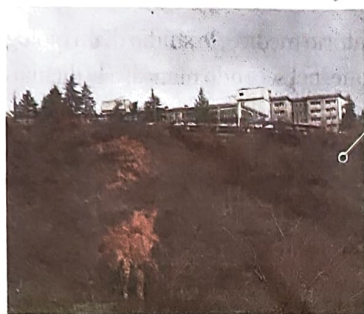
Lo smottamento del terreno a valle della rampa d'accesso all'ospedale Santissima Trinità
