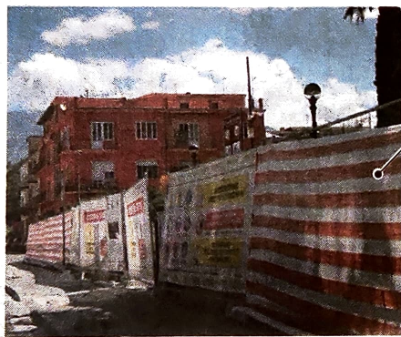
Il cantiere del parco Santa Chiara oggetto in queste settimane di un generoso restyling
