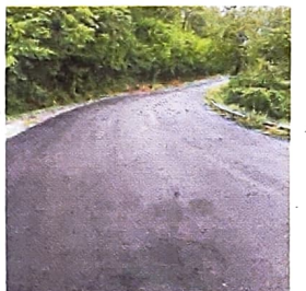
Un tratto interessato dai lavori
