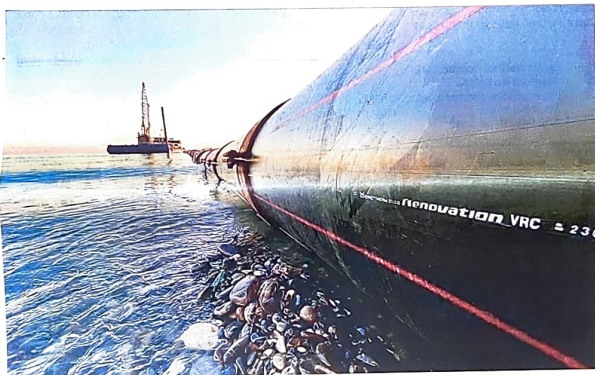
Blue Raman. L'infrastruttura di Sparkle in consorzio con Google (in foto il cavo atterrato a Genova) transiterà a nord dell'Egitto
