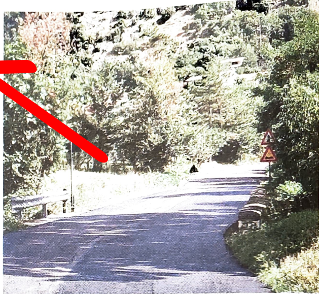
Due i tratti che beneficeranno degli interventi della Provincia
