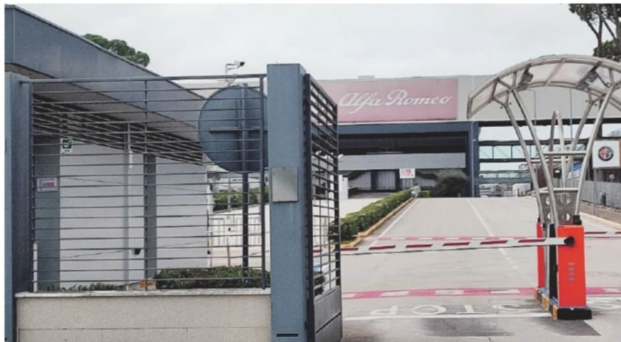
L'ingresso dello stabilimento Fca di Cassino
