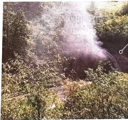
Il denso fumo nero sprigionato mercoledì dall'incendio dell'autoarticolato nella galleria Capo di China
