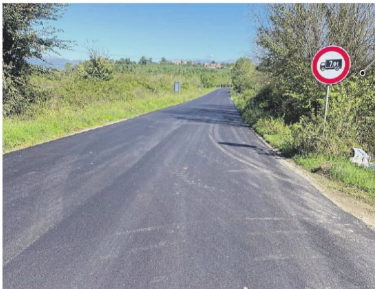
I lavori di bitumazione sulla Strada Provinciale n. 77 “Dei Santi”
