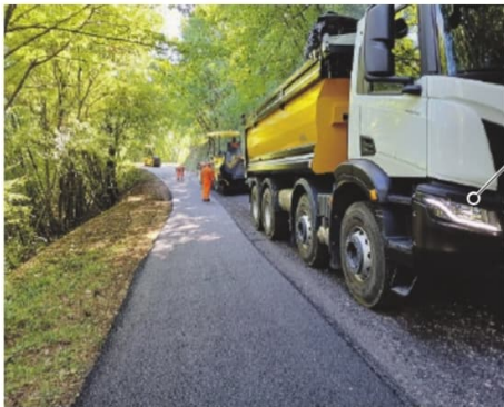
Il lavori in corso per il rifacimento dell'asfalto lungo la strada provinciale che collega Arpino e Casalvieri
