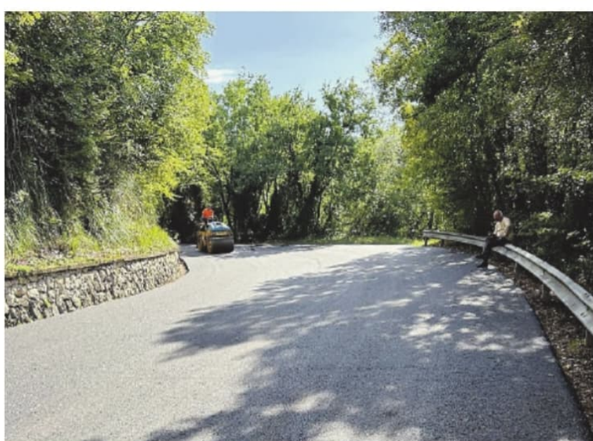
La strada provinciale 129 con il nuovo manto di asfalto
