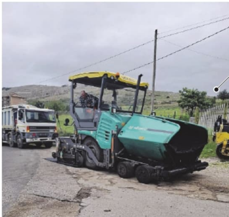
Operai e mezzi in azione su un tratto della provinciale Prenestina Antica per stendere il nuovo asfalto
