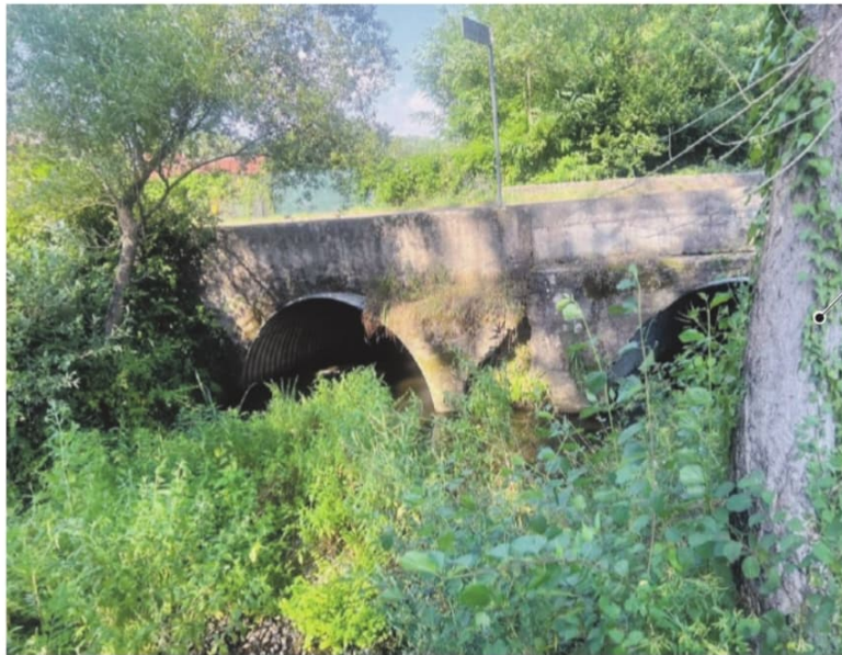
Nelle foto, i ponti nelle località Badia e Fontana del Gatto che a breve verranno interessati dai lavori di ripristino e messa in sicurezza
