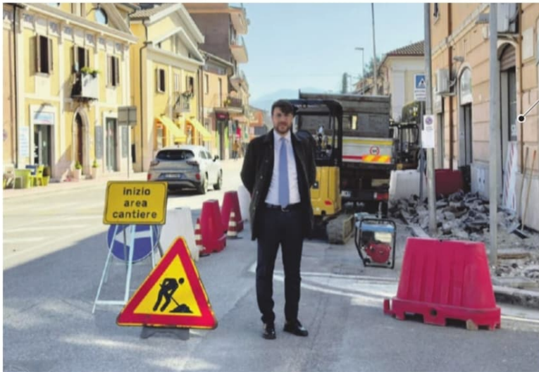
Il sindaco Luca Di Stefano durante il sopralluogo su un cantiere l'inverno scorso
