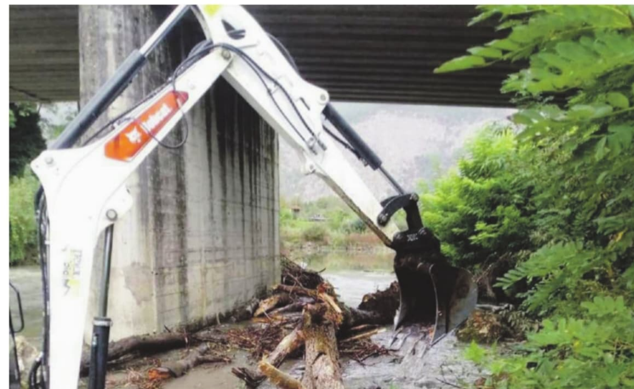
L'intervento del consorzio “Conca di Sora” per liberare l'alveo del Liri dal cumulo di tronchi nel tratto di via Salceto
