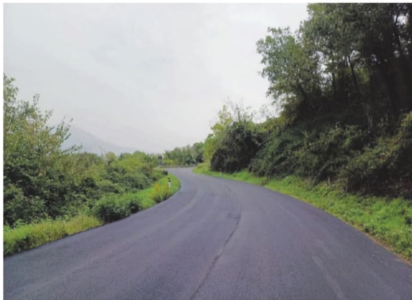
La strada provinciale 73 dopo i lavori di bitumazione
