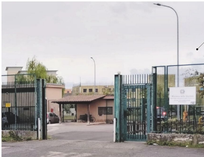
La casa circondariale di Frosinone soffre di alcune criticità più volte segnalate dalla Fns Cisl Lazio
