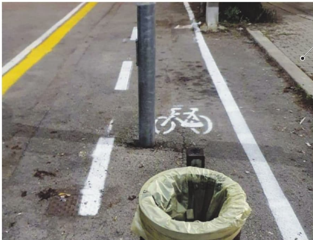
La pista ciclabile intercomunale che attraversa il parcheggio della zona Scalo
