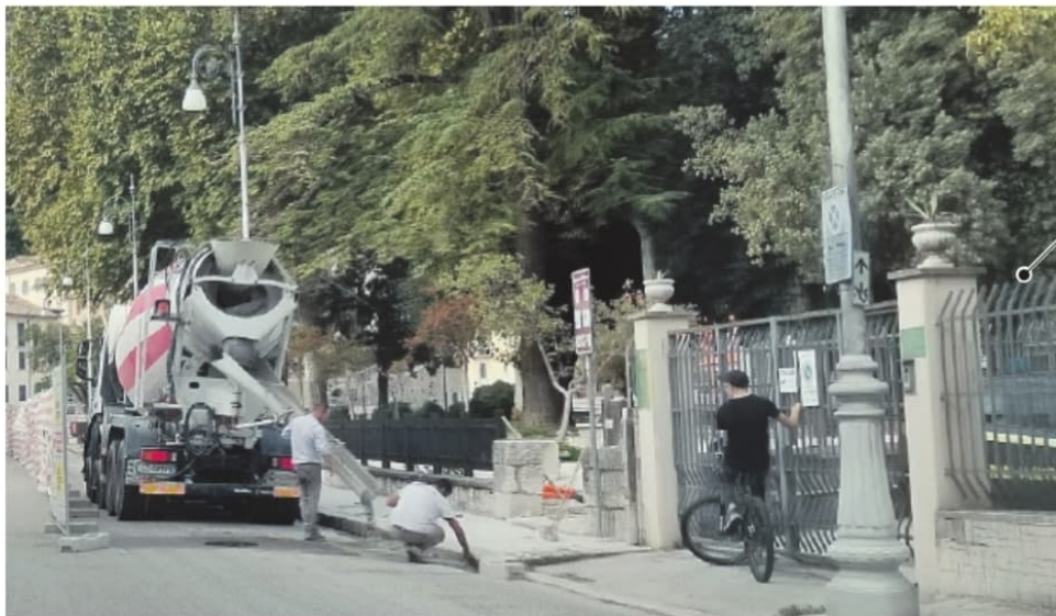
Gli operai impegnati nei lavori di rifacimento dei marciapiedi esterni del parco Santa Chiara
