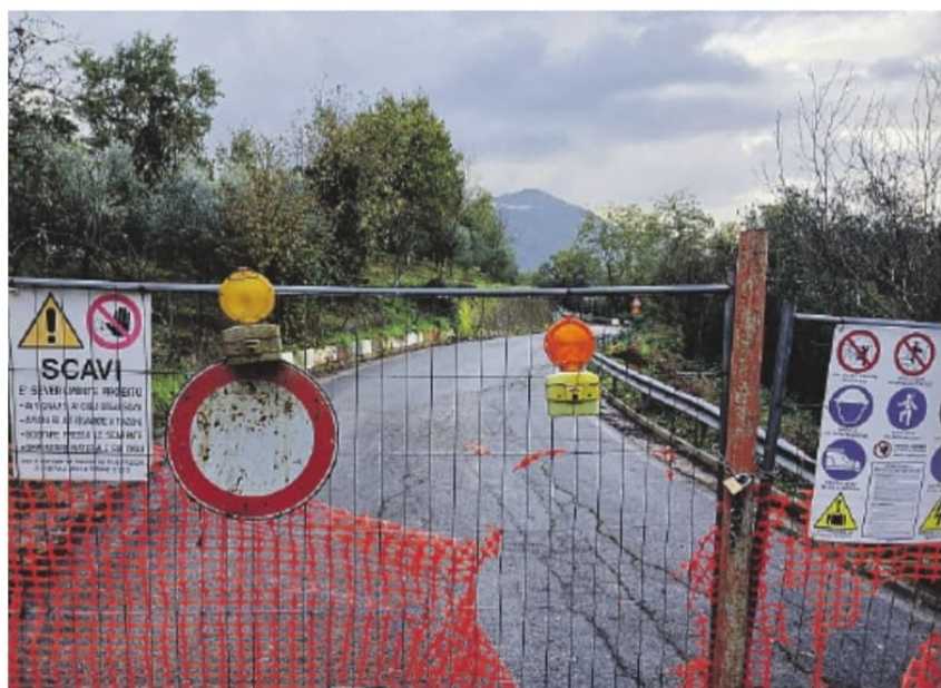
Il cantiere dei lavori in corso sulla strada provinciale 88
