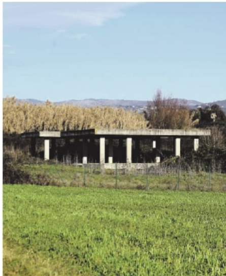
Lo scheletro in calcestruzzo del canile comunale nella zona di Radicina
