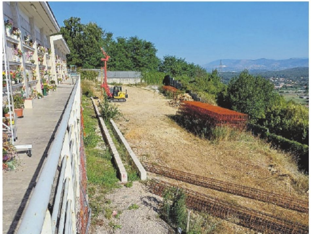
Il cantiere per la costruzione dei nuovi loculi
