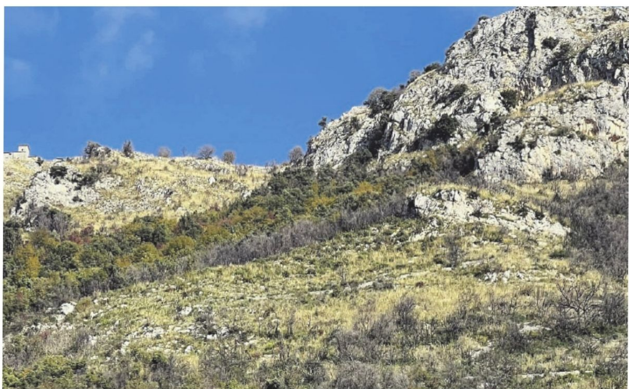
La zona interessata dalla frana, sotto alcuni sopralluoghi
