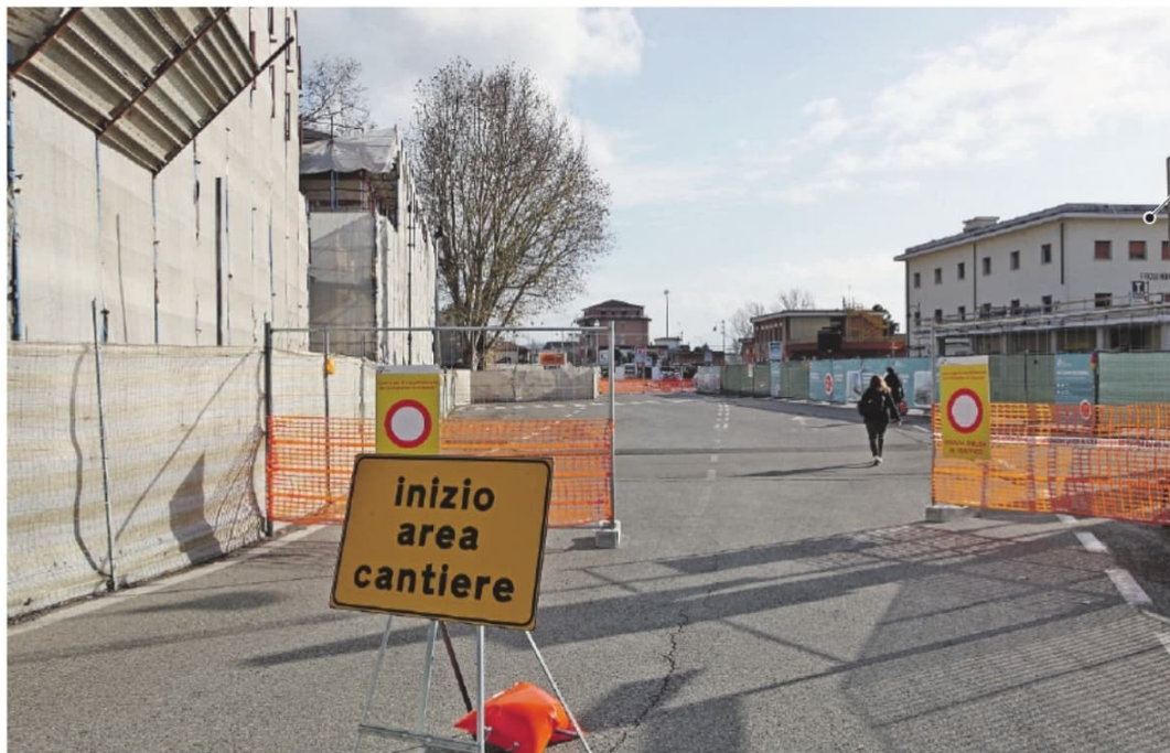
Piazzale Kambo interdetta al traffico per i lavori di restyling della stazione ferroviaria FOTO MASSIMO SCACCIA
