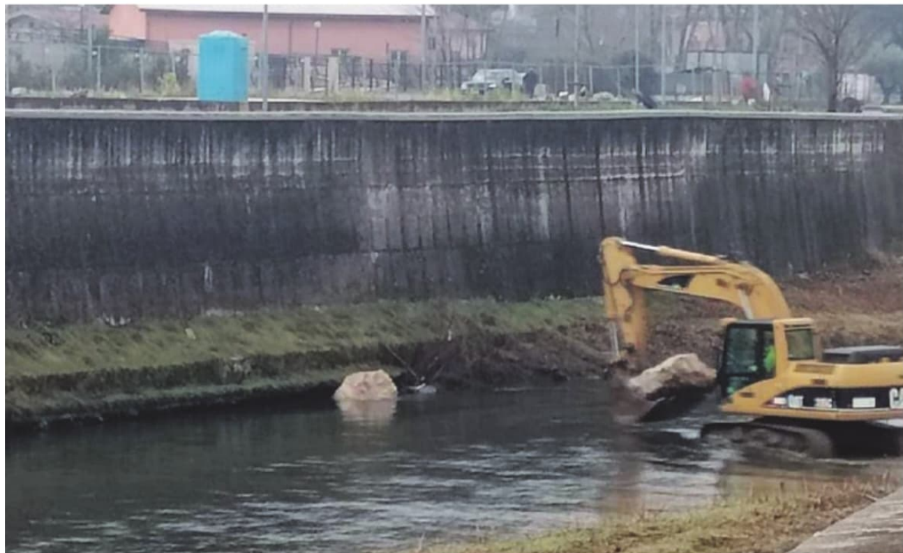
Un escavatore in azione nel tratto cittadino del fiume Liri
