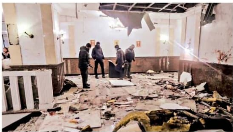
▲ Il luogo dell'attacco L'ingresso del complesso residenziale "Vele sciarlatte", a Mosca, dopo l'esplosione
