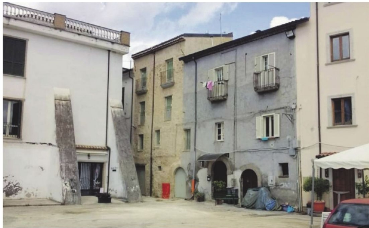
Una parte dei lavori di riqualificazione conclusi nel centro storico
