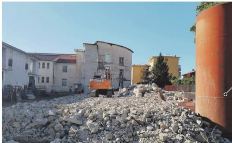
A sinistra, il cantiere per l'asilo nido in località San Rocco. Sotto, da sinistra, i lavori in località Ruscitto, il palazzo degli studi "Simoncelli" e l'area del cantiere a Santa Rosalia
