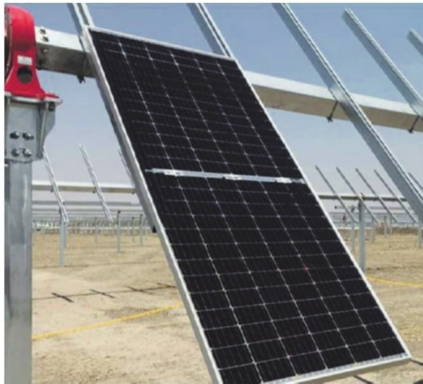
Nell'immagine un parco fotovoltaico in costruzione
