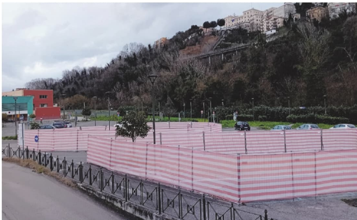
Il cantiere nell'area dell'ascensore inclinato FOTO MASSIMO SCACCIA
