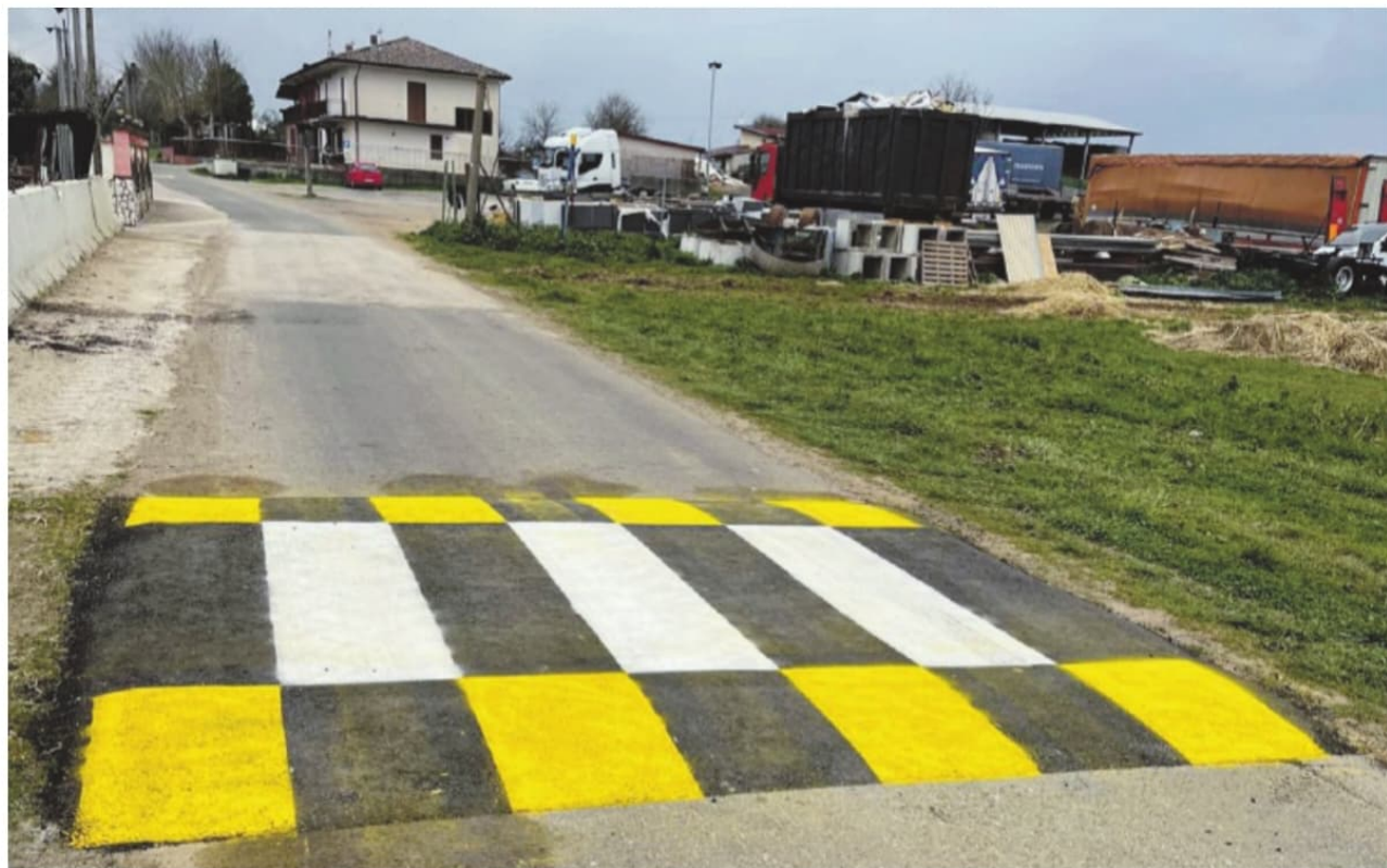
Il nuovo attraversamento pedonale rialzato realizzato in via Capannaccio
