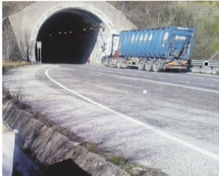
La galleria Capo di China lungo la superstrada Sora-Cassino
