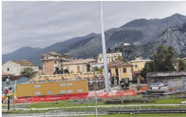
I lavori per la realizzazione del sistema Ertms alla stazione di Sora
