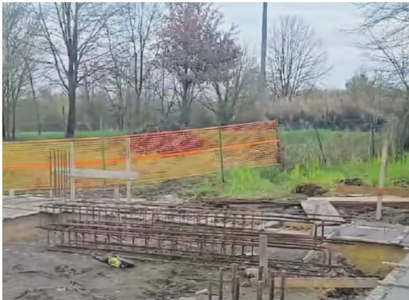
Il cantiere del nuovo asilo nido comunale in località Vallebona
