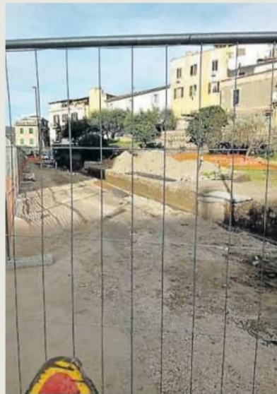
Il cantiere ad Anagni
