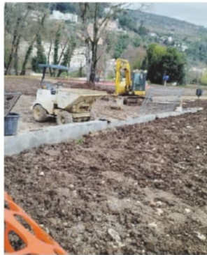
I lavori in corso alla villa comunale
