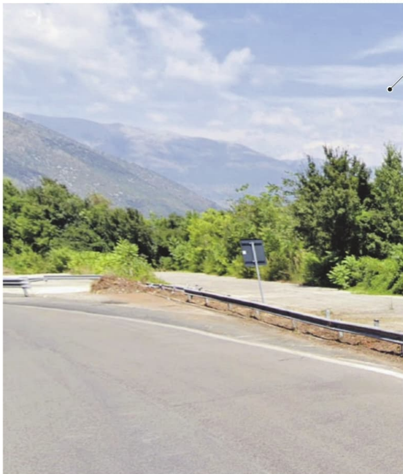
L'ultimo tratto della Ferentino - Avezzano da completare nei pressi dell'uscita di Sora
