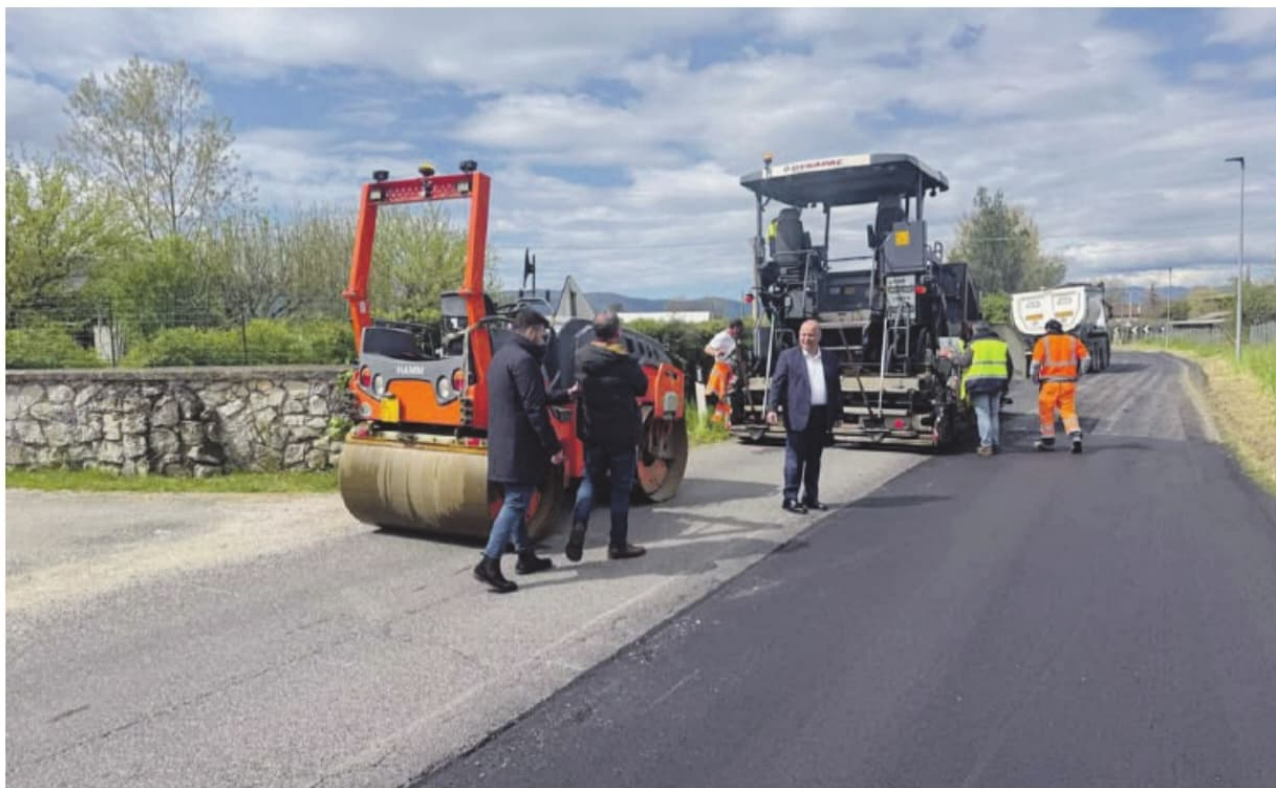
I lavori di asfaltatura iniziati ieri su via Caragno grazie alla sinergia tra Comune e Provincia
