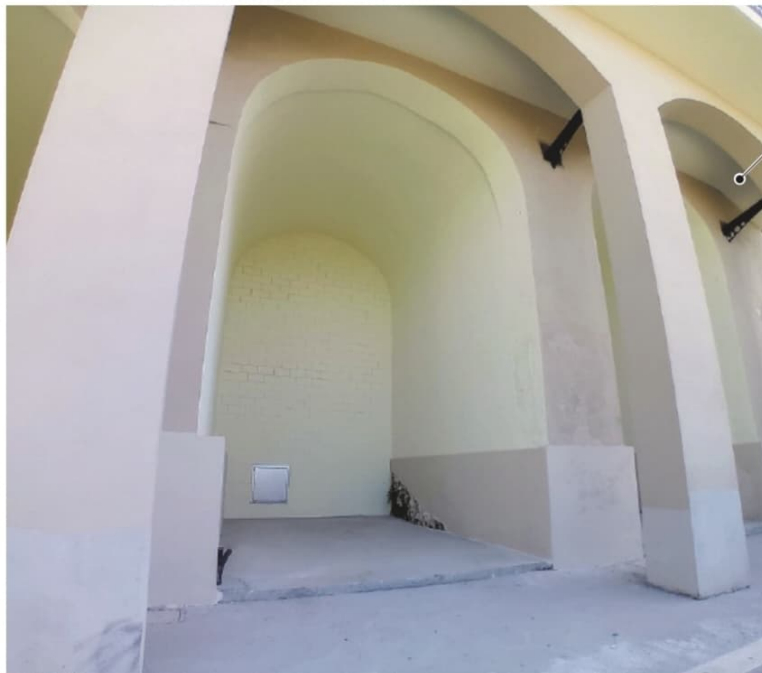
La riqualificazione delle arcate dei Piloni è praticamente conclusa FOTO MASSIMO SCACCIA
