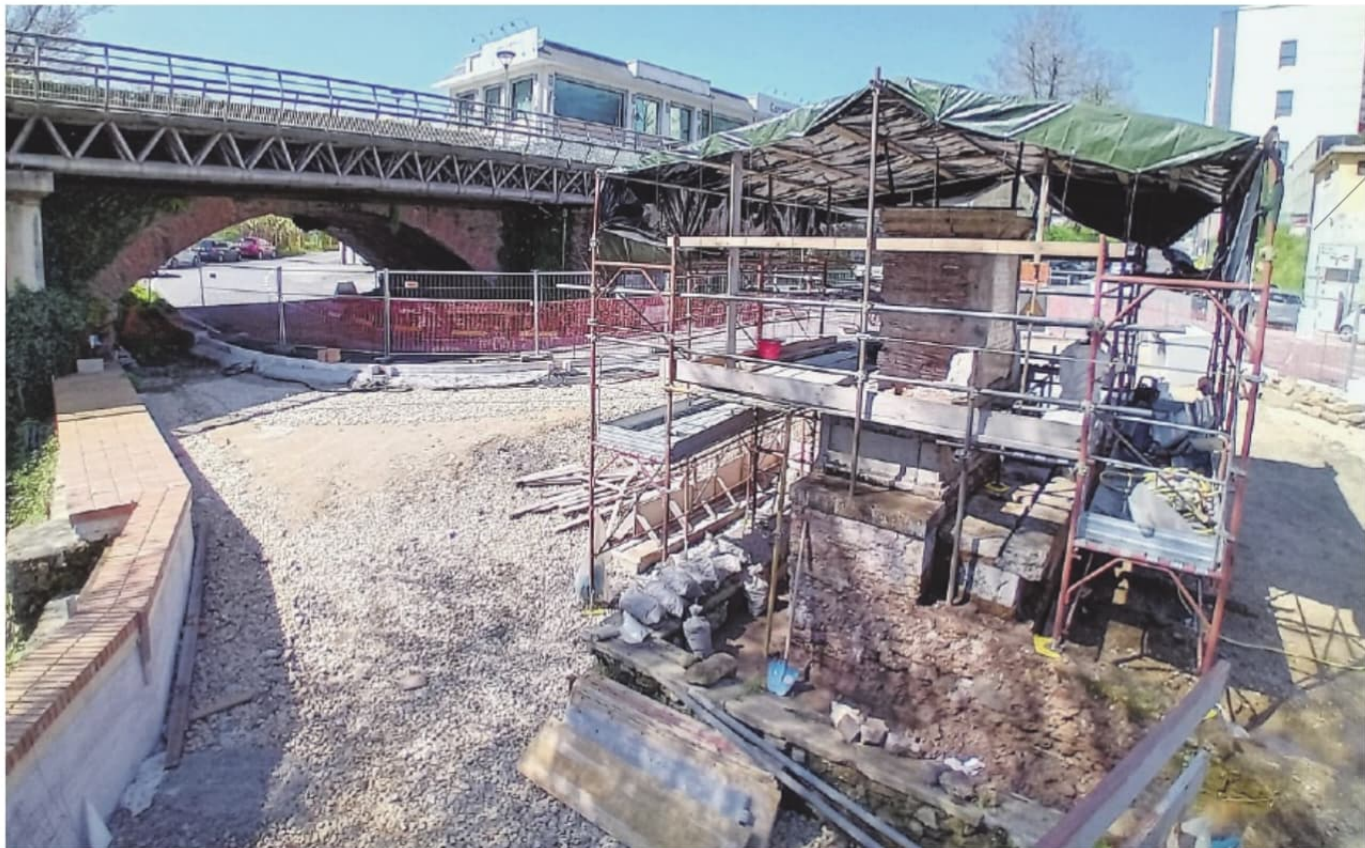
Il cantiere della Fontana Bussi FOTO MASSIMO SCACCIA
