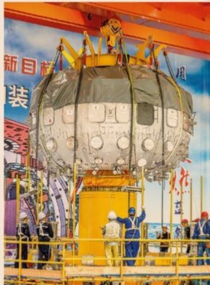
Il futuro dell'energia. Il sito di installazione dell'HLM-2M Tokamak, il sole artificiale di nuova generazione della Cina, a Chengdu, nel Sichuan
