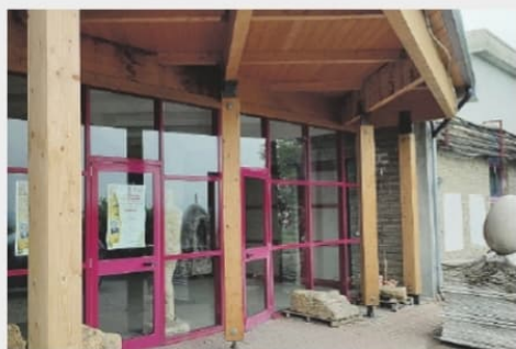
L'Osservatorio Geofisico "Valle del Liri" a San Giovanni Incarico
