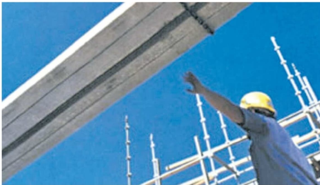
Un operaio al lavoro su un cantiere
