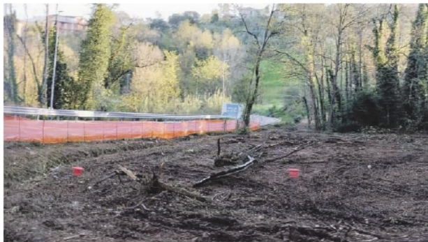
Un'immagine dei lavori in corso in località Forcella
