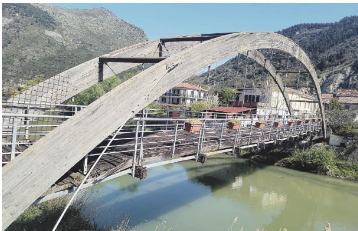
Il ponte lamellare “Cristini” che mostra un evidente inclinamento
