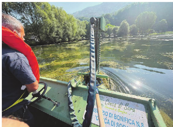
Manutenzione da parte del Consorzio di Bonifica Conca di Sora
