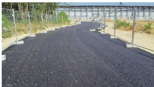
Iter burocratico e organizzativo incompleto per la provvisoria strada dei tifosi
