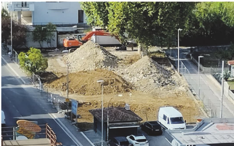
I lavori nell'area del futuro hub trasportistico di via Tiburtina
