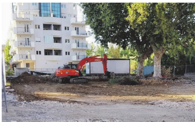
I lavori attualmente in corso a via Tiburtina
