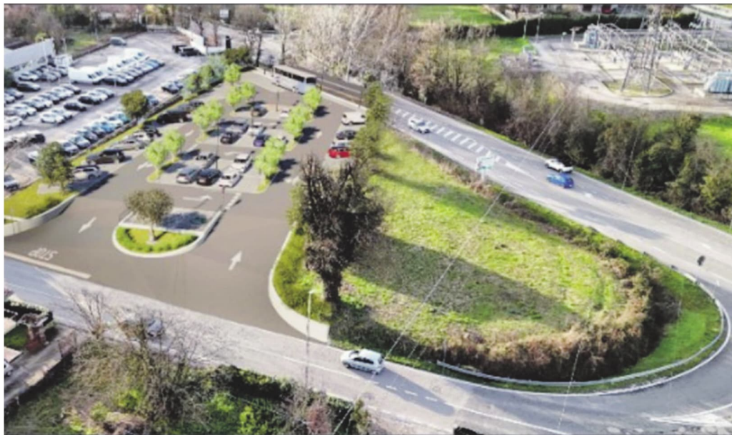
In alto il futuro parcheggio di via Mària e sotto l'area ex Agip di via Refice che sarà riconvertita
