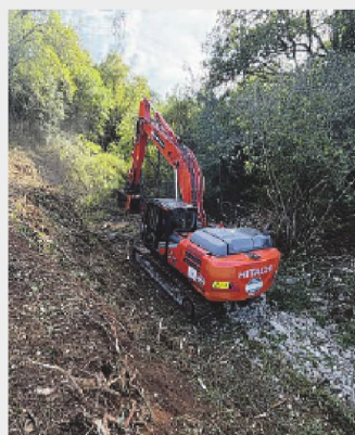
I lavori nell'alveo del Fosso Mastro
