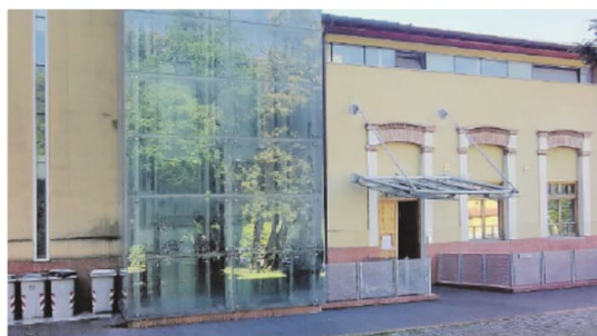
La sede ristrutturata della nuova Casa della comunità
