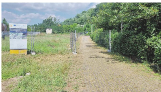
Il cantiere del raddoppio dell'ascensore non è mai partito
