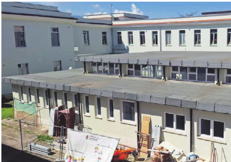
Un'immagine del cantiere della mensa scolastica
