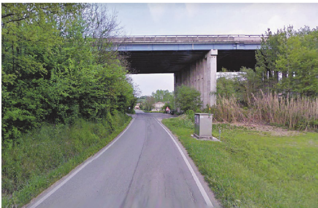
Il ponte dell'autostrada A1 che sovrasta l'area dei pozzi di via Marano
